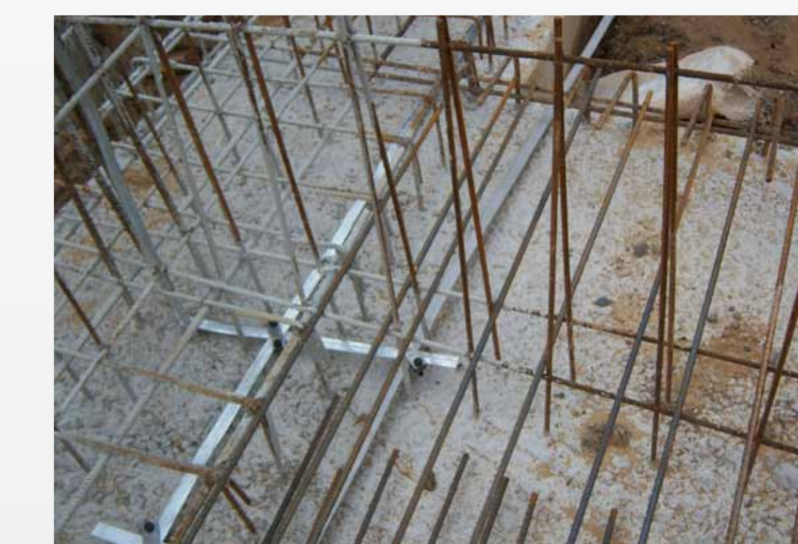
Verbindung von Potentialausgleichser und V4A-Erder
