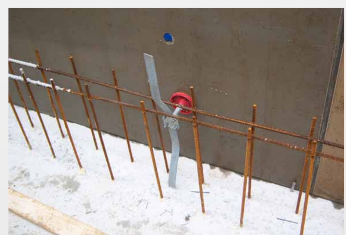
Erstellung von Erdungsfestpunkten in geschalten Betonwänden
