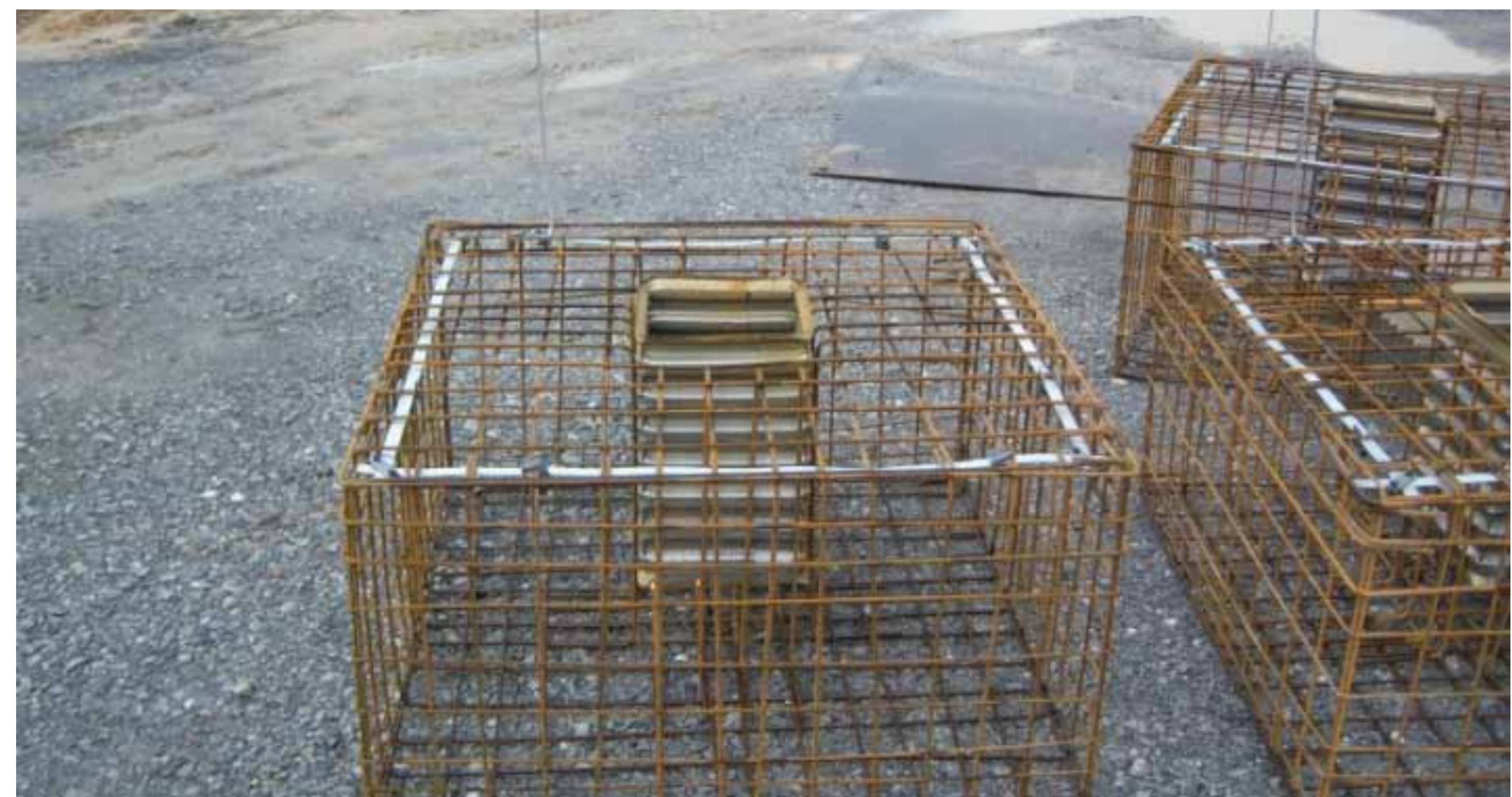
Bild 1: Erstellen von Einzelfundamenten mit einem verzinkten Erder und einer Anschlußfahne aus Edelstahl V4A
