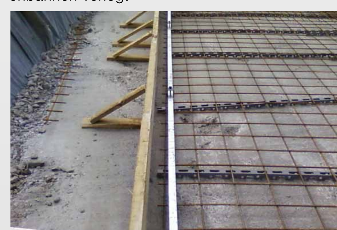
Verzinkter Fundamente in der Bodenplatte verlegt mit V4A-Anschlößfahne
