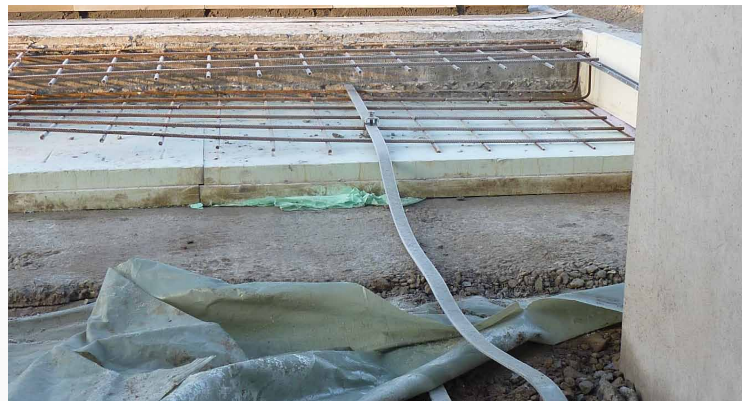
Bild 3: Querschnitt einer Erdungsanlage mit einem vermaschten Ringerder aus Edelstahl V4A unterhalb der Bodenplatte (unten) und einem Potentialausgleichser in verzinkter Ausführung in der Bodenplatte (oben)
