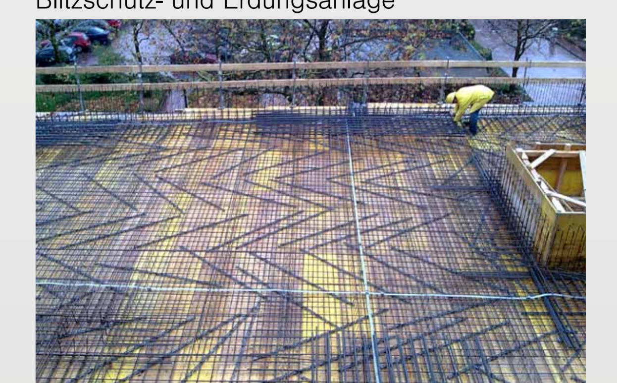
Darstellung des verzinkten Fundamentes in einer bewehrten Zwischendecke
