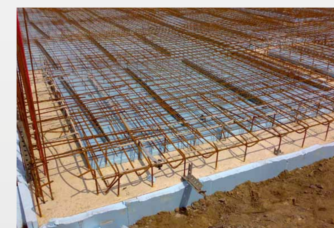
Bodenplatte mit außen- und innenliegender Perimeterdämmung
