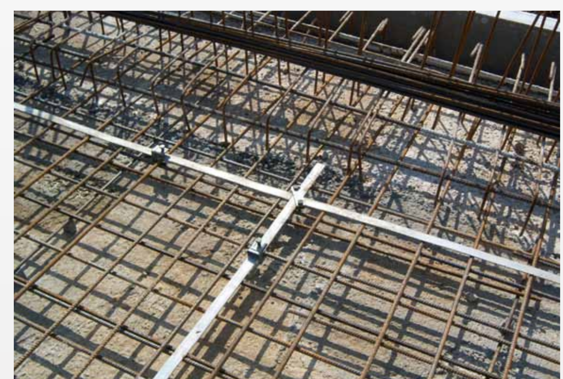
Verbindungs- und Anschlößklemmen eines Fundamentes
