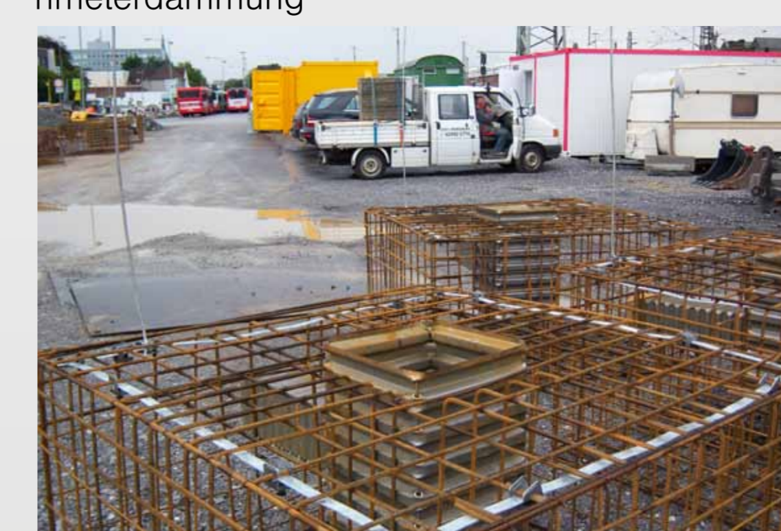
Verzinkter Fundamente für Köcherfundamente mit V4A-Anschlößfahne
