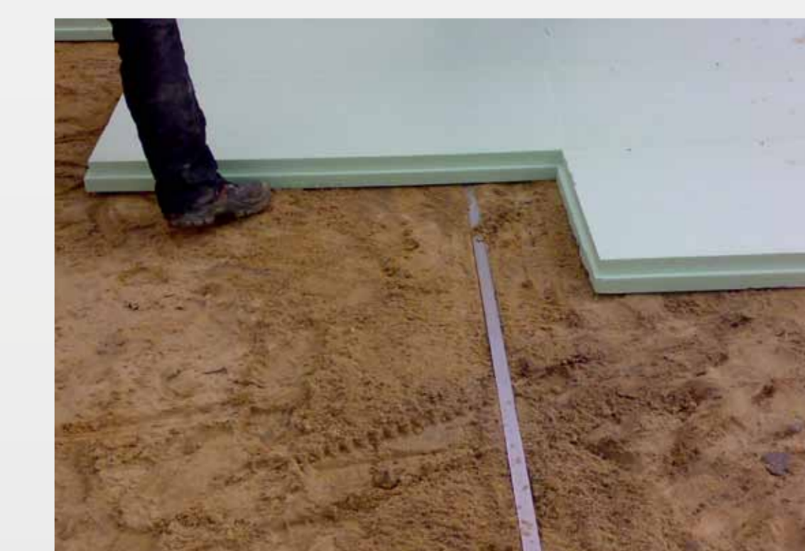
Verlegung des vermaschten V4A-Erdes unterhalb einer Perimeterdämmung
