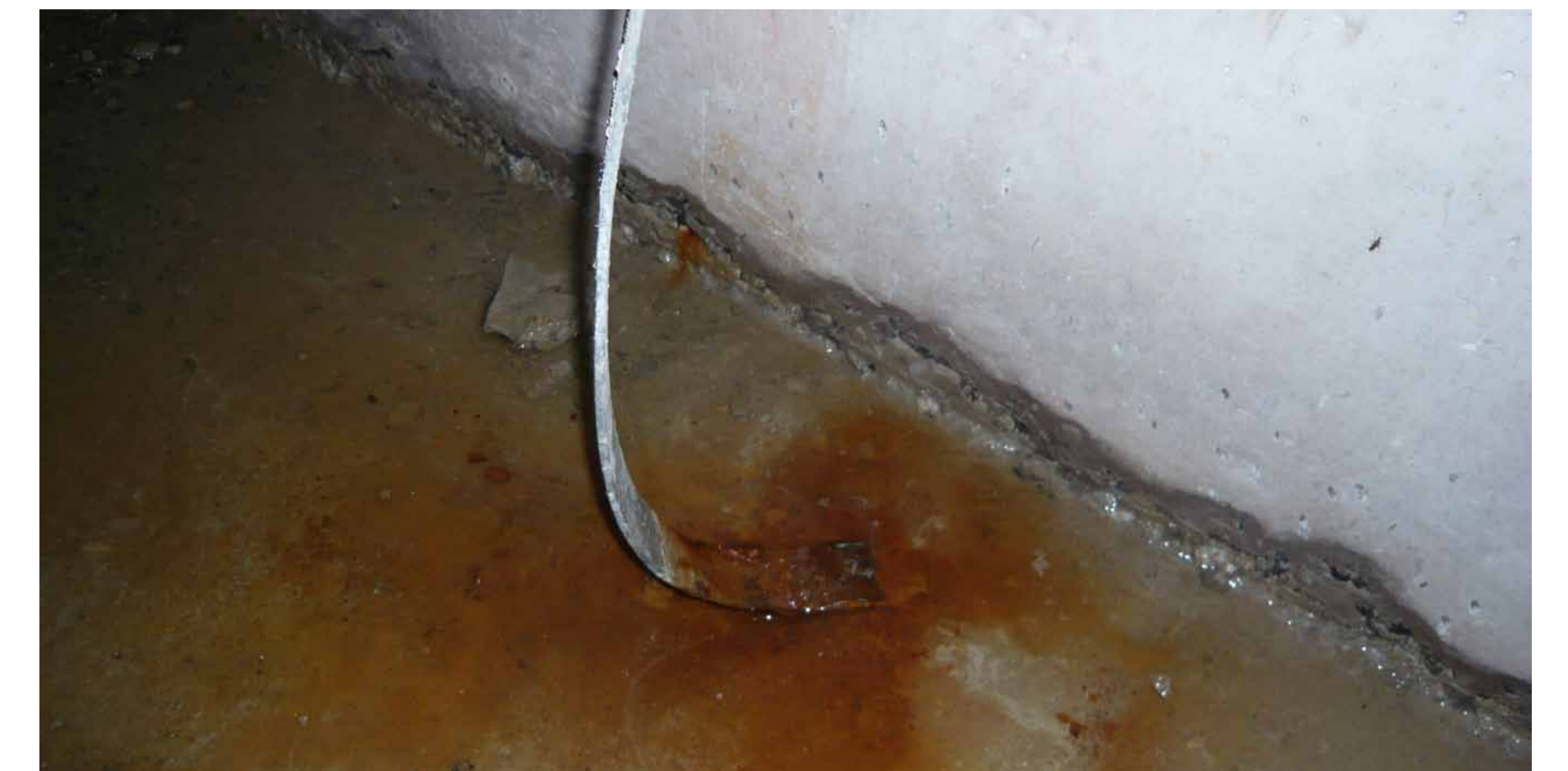
Bild 4: Korrodierte Anschlößfahne aus verzinktem Bandstahl 30 x 3,5 mm in einem Neubau, nachdem der Keller aufgrund eines starken Regenschauers vollgelaufen war.
