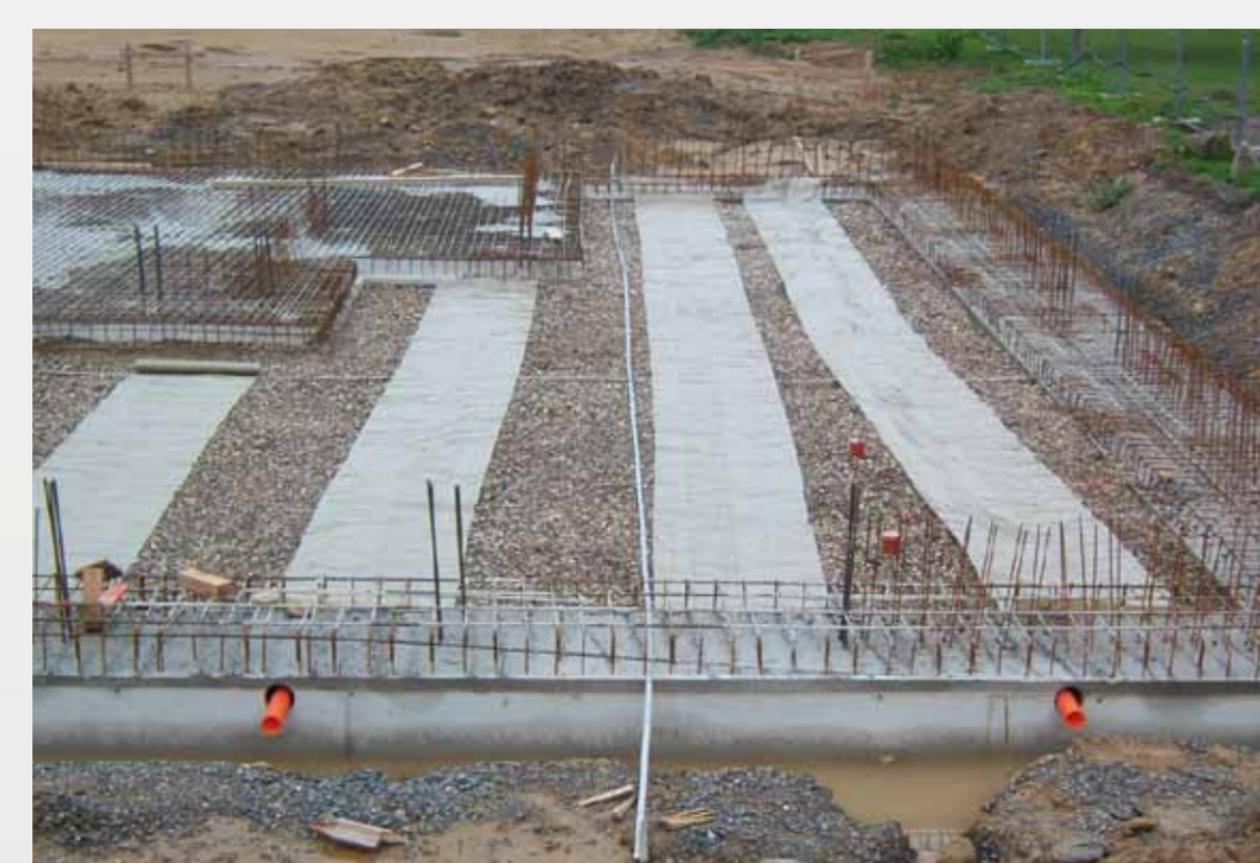
Vermaschter V4A-Ringerder unterhalb von Folienbahnen verlegt
