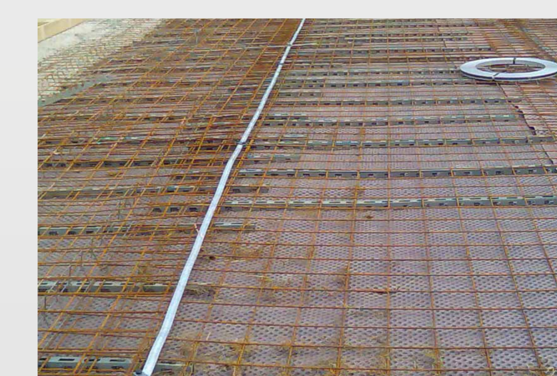
Potentialausgleichser in der Bodenplatte mit darunter liegenden Noppenbahnen
