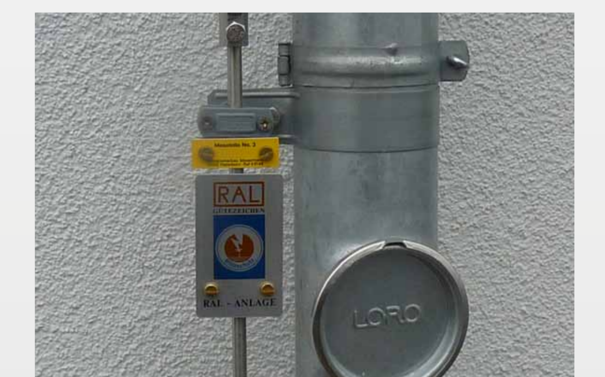
RAL-Schild an einem Gebäude mit errichteter Blitzschutz- und Erdungsanlage
