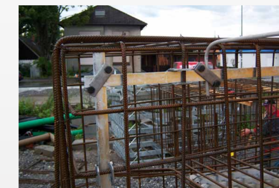
Anschlößklemmen mit Anschlößfahnen für Köcherfundamente
