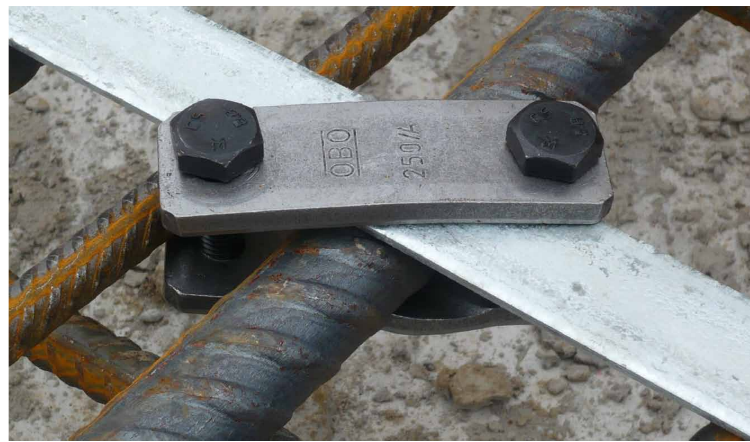
Bild 2: Armierungsanschlößklemme (OBO Typ 250) als technisch korrekte Verbindung zwischen dem Fundamente der Bewehrung.
