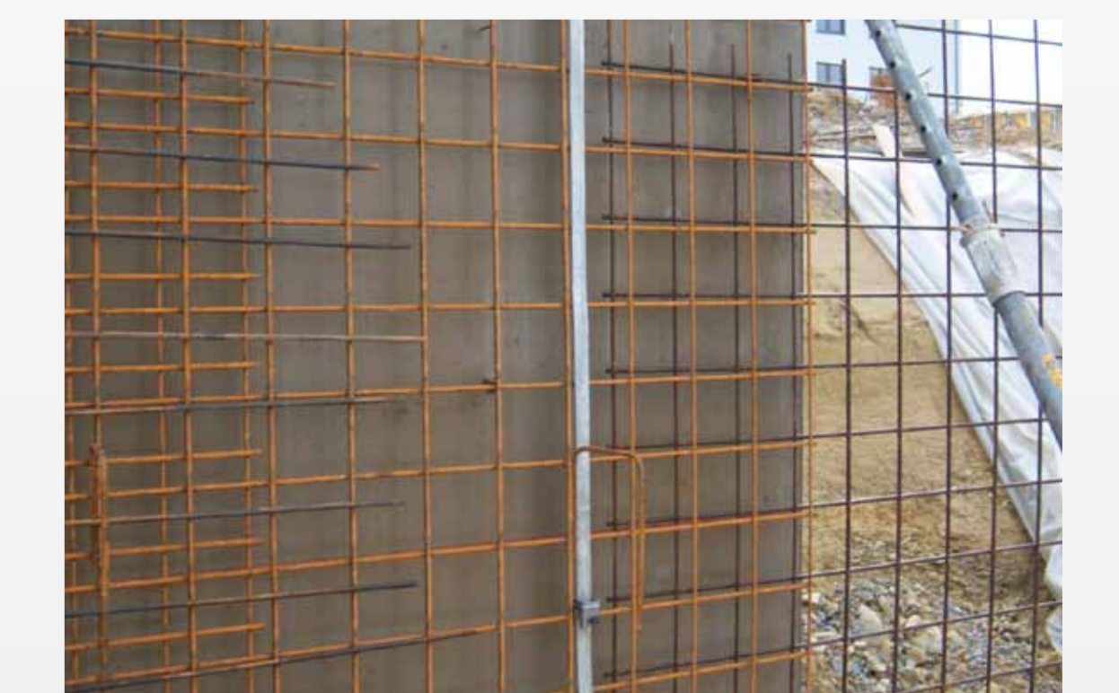
Erstellung von Ableitungen in geschalten betonwänden mit Anschluß an die Bewehrung
