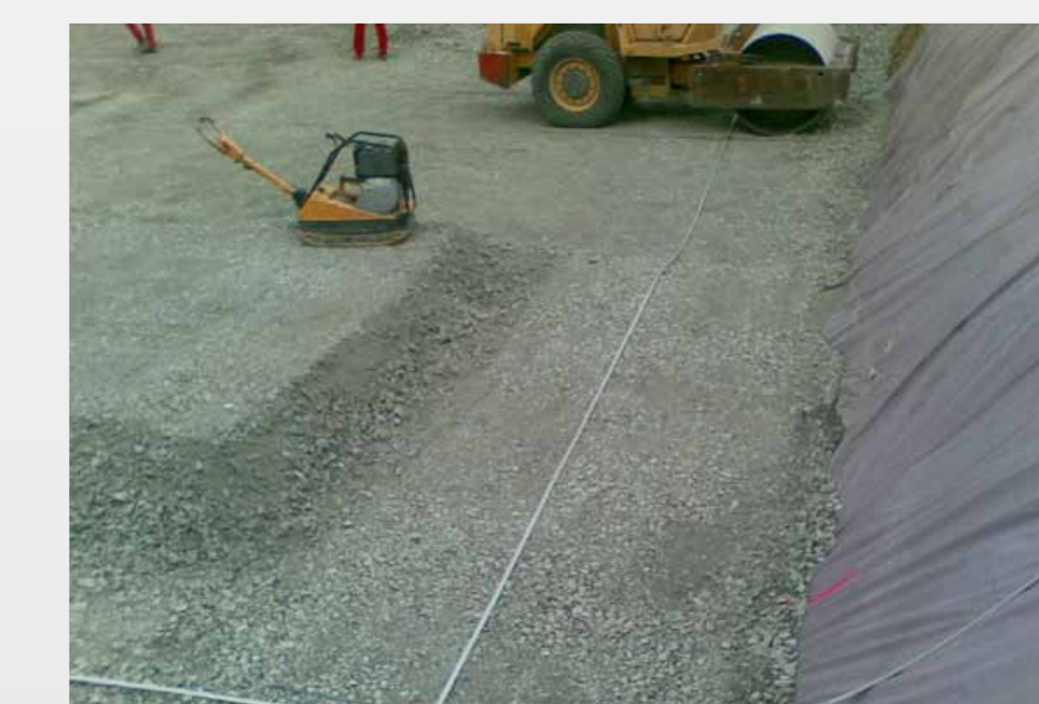
Verlegung des vermaschten V4A-Erdes unterhalb der Bodenplatte
