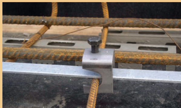
Bild 1b: Stromtragfähige, sichere elektrische Verbindung (Armierungsklemme.)
