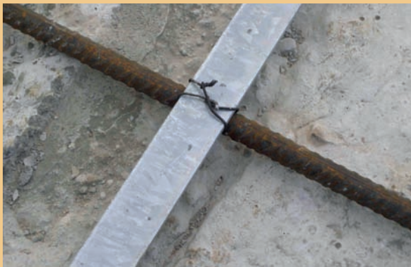
Bild 1a: Röhrenverbindung nur zulässig als Lagefixierung.
